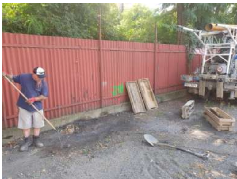
Skartace vrtu zpětným záhozem a úklid pracoviště. Zbytný vytěžený materiál byl odvezen.
